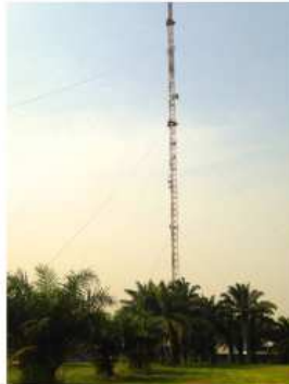
Site émetteur d'Abobo, Abidjan
