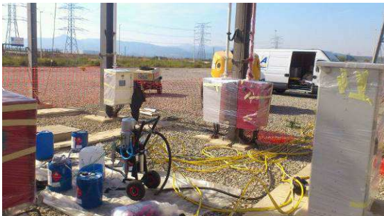
Impermeabilización de zona de productos químicos en trabajos de siliconado sylgard
