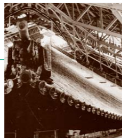
1974年 トロリーコンベヤ 東大寺大仏殿の大修理で採用
