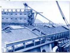
▲1953年 穀物・バラ物の荷揚げ設備「バレルベヤ」
