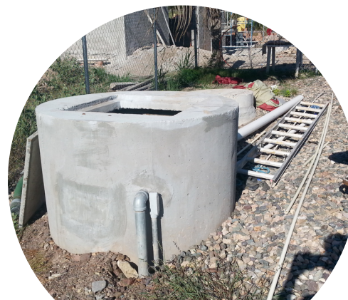
EXTERIOR DE CÁRCAMO DE BOMBEO
