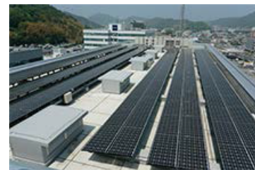
本社社屋の屋上に太陽光発電パネルを設置
