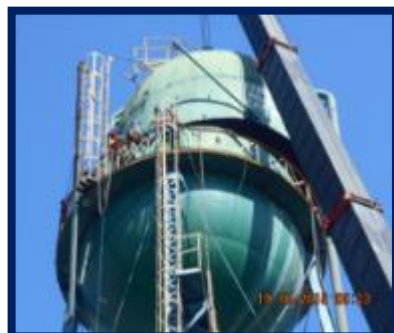
Desmontaje del Tanque elevado
