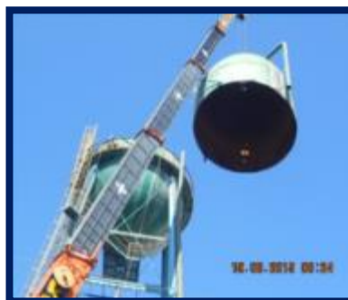
Desmontaje del Tanque elevado
