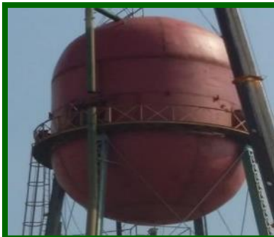
Fabricación y montaje del nuevo Tanque elevado
