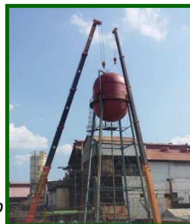
Fabricación y montaje del nuevo Tanque elevado
