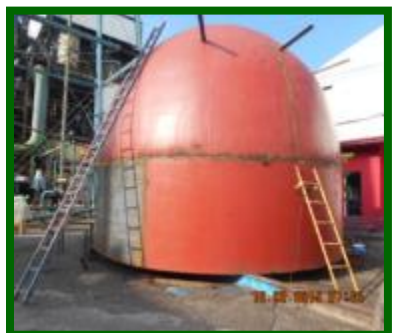
Fabricación y montaje del nuevo Tanque elevado
