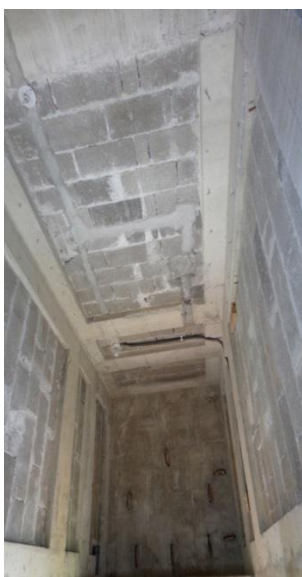
OBRA CIVIL – CONSTRUCCIÓN DEL FOSO
