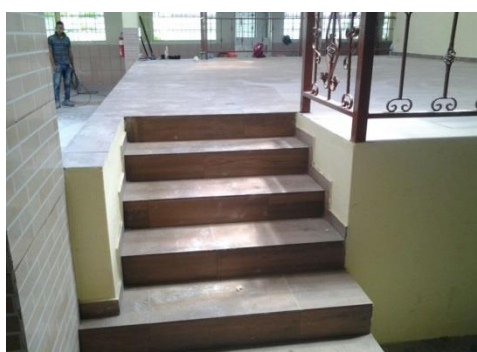
ESCALERA DE ACCESO
