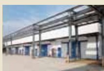
第2工棟危険物倉庫の外観
