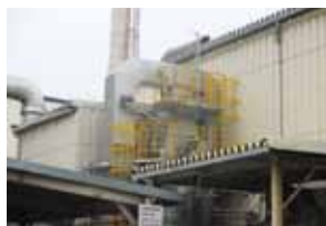
焼却炉ボイラーにエコマイザーを設置(龍野工場)
