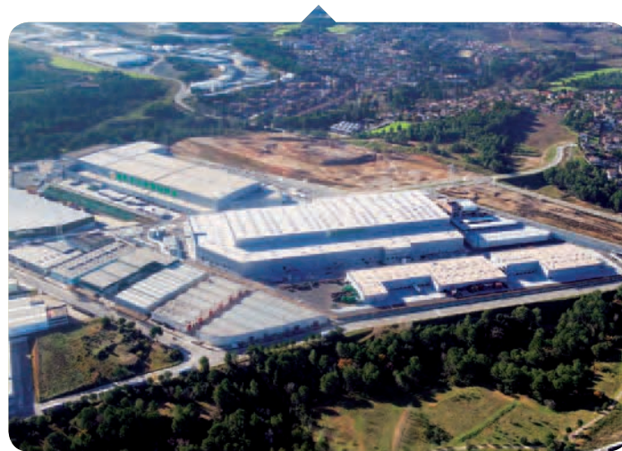
Obras del bloque logístico de Abrera, Barcelona.
