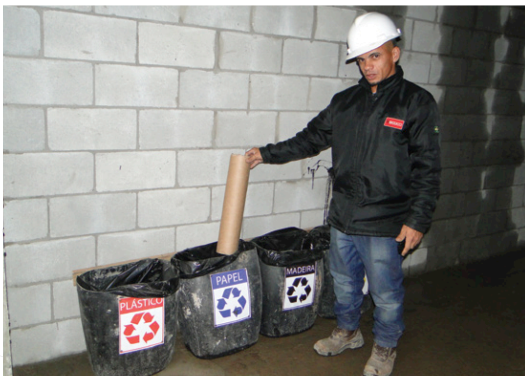
Colaborador Romildo Santana na coleta seletiva da obra Wynn Tower MBigucci
