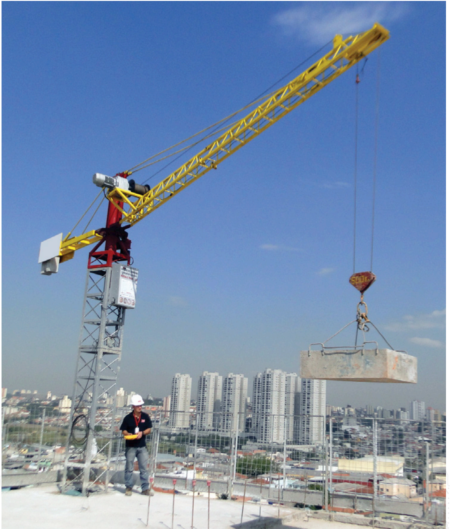
Obra do empreendimento residencial Piemonte MBigucci, em construção no Bairro Saúde / SP
