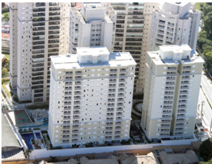
Empreendimento residencial Status MBigucci, entregue em São Caetano do Sul / SP
