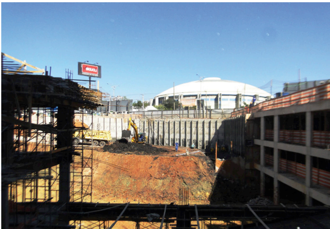
Marco Zero MIX, empreendimento misto (lofts e salas comerciais) em construção em São Bernardo do Campo / SP
