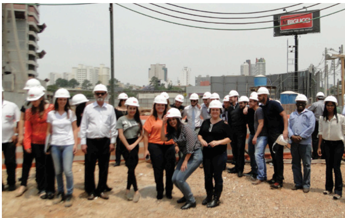
Colaboradores visitam a obra do Marco Zero durante evento de aniversário da MBigucci
