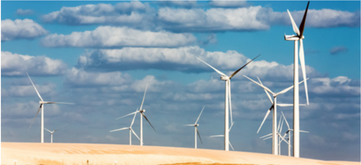
REI DOS VENTOS WIND FARM (RN)
