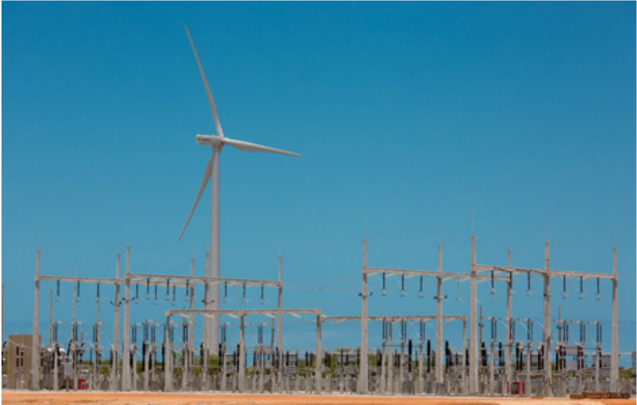
REI DOS VENTOS WIND FARM (RN)
