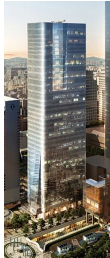
파르나스타워 · 위치 : 강남구 삼성동 · 지상38층의 호텔과 오피스동으로 구성 · Pre-Con 공사 시범 적용하여 공사비 100억 감축
