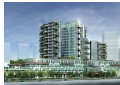
Ng Teng Fong Hospital · 위치 : 싱가포르 · 공사기간 : 2012.06~2015.05
