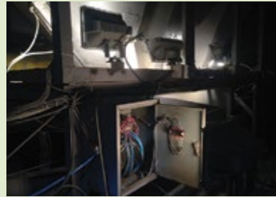
원주강릉철도7공구 현장 : 동절기에 할로겐등(발열등)을 이용하여 시설물의 동결을 예방함으로써 에너지 절감 및 폐기물 발생 제로화
