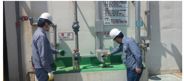
유해화학물질 설비 점검
