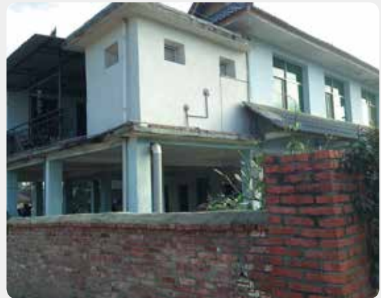
景洪民生村镇银行支持西双版纳傣族村民修建房屋
