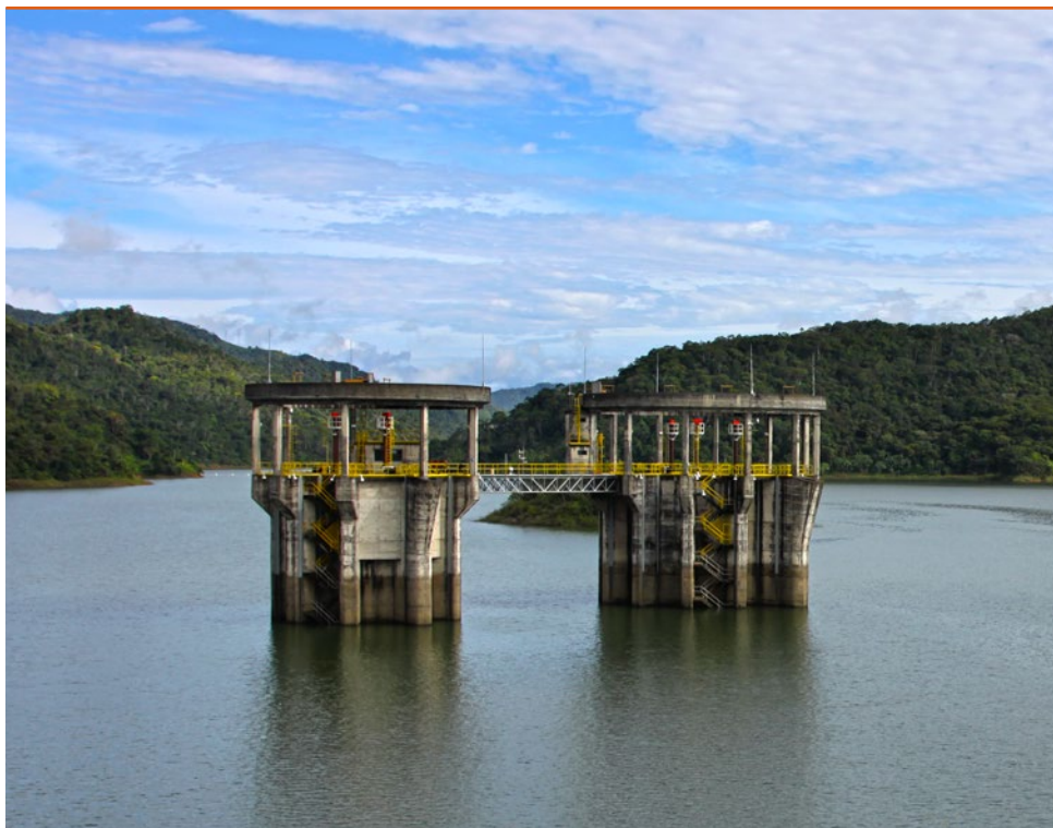
▼ Torres de captación. Central Hidroeléctrica San Carlos.
