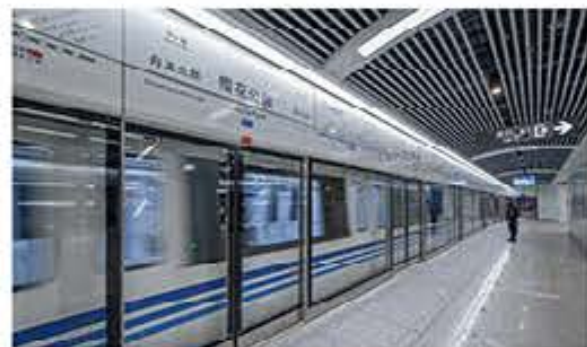
本行宁波分行信贷支持的宁波轨道交通钱湖站项目
