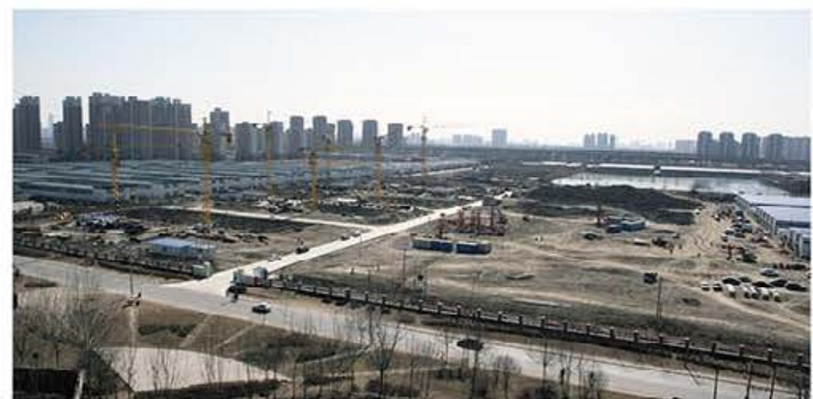
本行天津分行支持的棚户区改造现场
