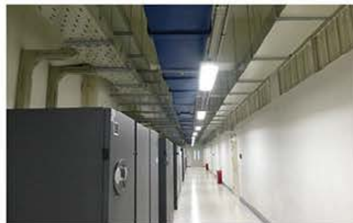
照明系统改造
