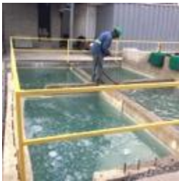
Tina para el lavado de los camiones concreteros
