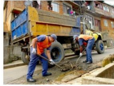
Mantenimiento manual de sumideros
