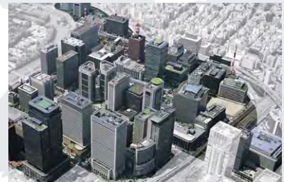
大手町地区・丸の内一丁目地区他・地域冷暖房 (東京都千代田区)
