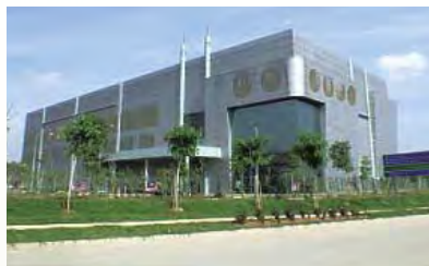
プトラジャヤ地区1 DCSプラント(マレーシア)
