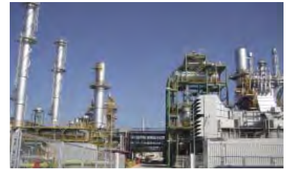
PTT Utility社 セントラルユーティリティプラント2(タイ)
