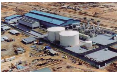
クアラルンプール国際空港 CGS/DCS プラント(マレーシア)
