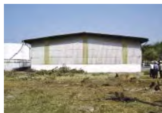
石綿スレート板 除去前の倉庫
