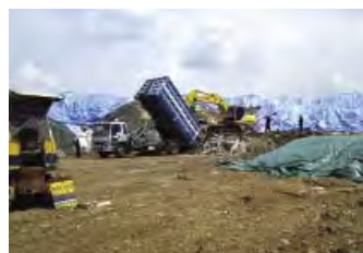
石綿スレート板を廃棄物処理場に埋立て処分
