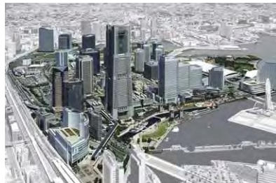
みなとみらい21中央地区・地域冷暖房 (神奈川県横浜市)
