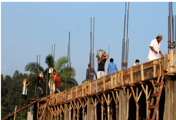
Participación de los estudiantes en el colado de la construcción
