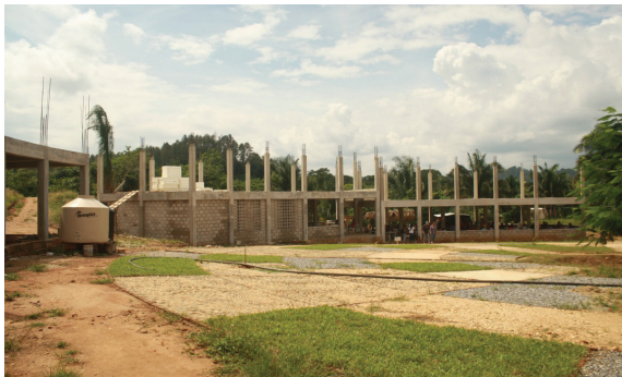
Construcción en proceso
