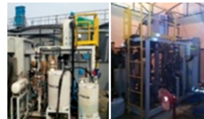
수도권 고속철도 수서~평택9공구 현장
