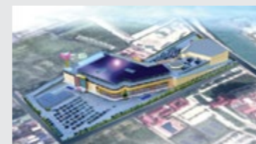
AEON Complex Mall · 위치 : 캄보디아 · 공사기간 : 2012.12~2014.06
