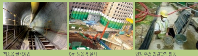
저소음 굴착공법 8m 방음벽 설치 현장 주변 민원관리 활동
