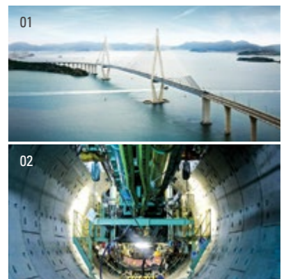
01 목포대교 · 위치 : 전라남도 목포시 · 공사기간 : 2004.11~2012.12 02 Downtown Line No.2 C913 · 위치 : 싱가포르 · 공사기간 : 2009.09~2015.07
