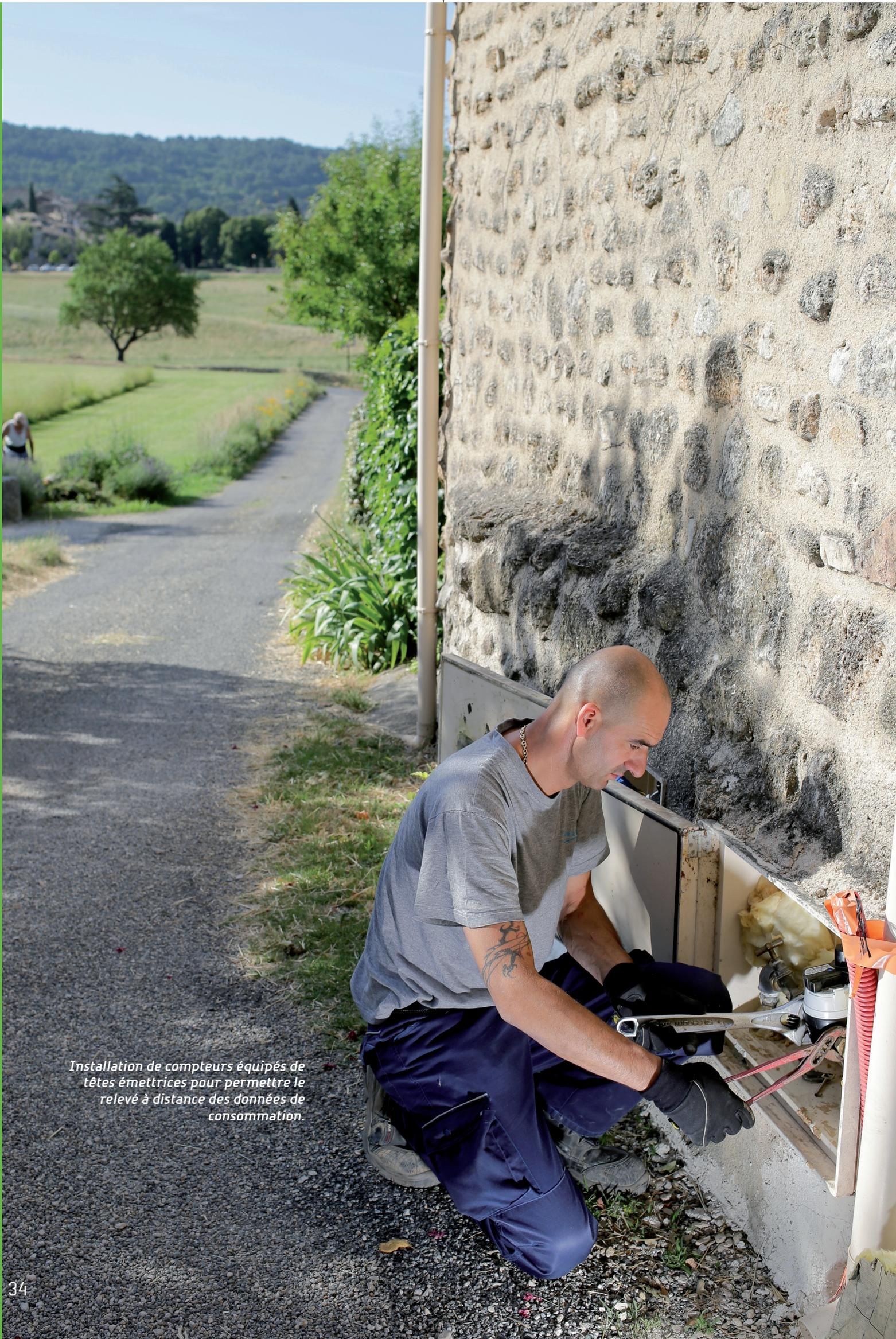
*Installation de compteurs équipés de têtes émettrices pour permettre le relevé à distance des données de consommation.*
