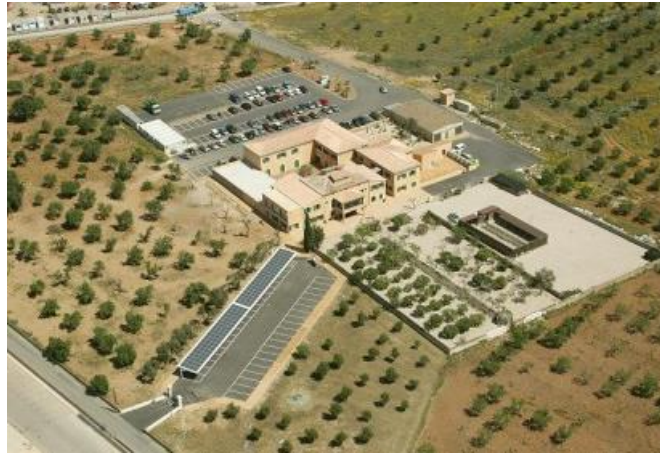
Oficinas centrales de TIRME (Cases de Can Canut).
