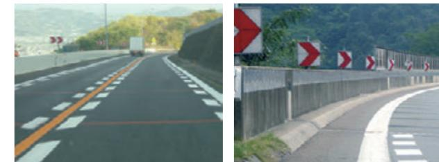
※1 高機能舗装:車が巻き上げる水しぶきが減り視認性が向上するほか、すべり摩擦係数が高くなるため、雨天時の走行安全性の向上、交通事故の防止に有効な舗装。
