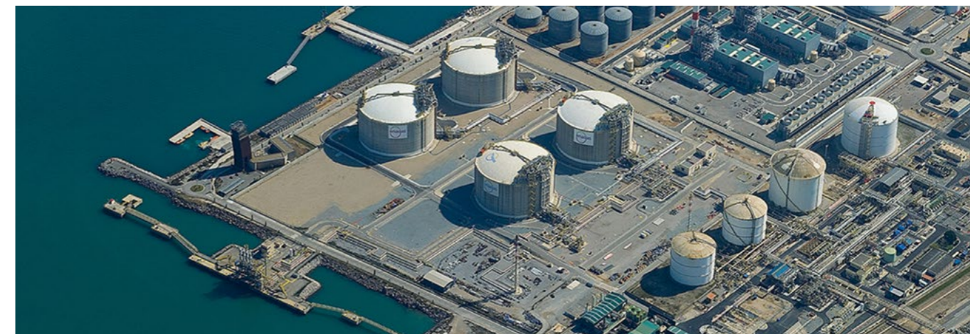
Terminal de GNL. Barcelona. Imagen cortesía de ENAGÁS.
