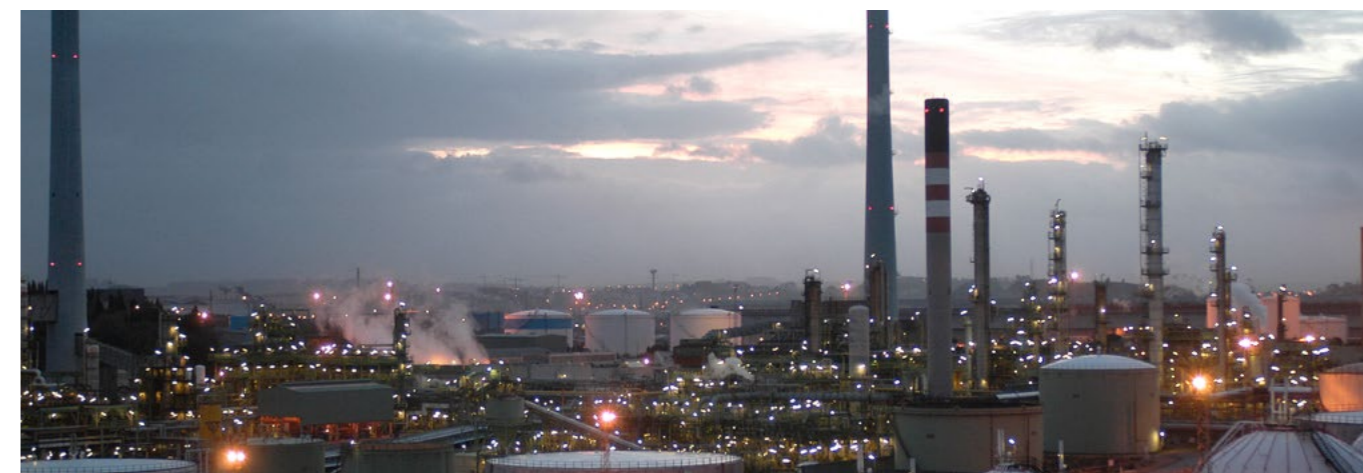
Refinería REPSOL La Coruña. Imagen cortesía de REPSOL.
