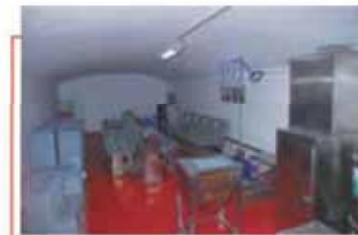
1. 辽宁二道沟公司井下避灾避险硐室
