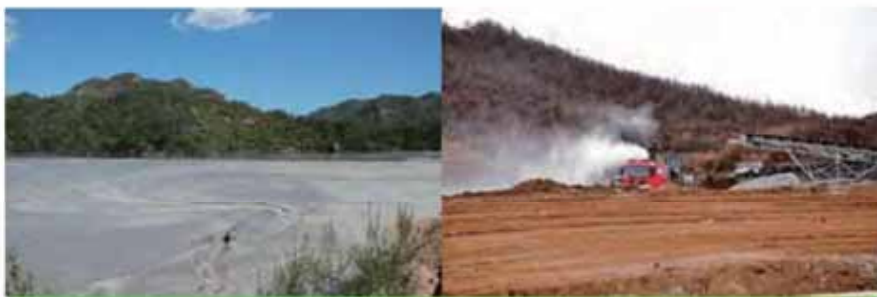
河北石铜公司尾矿库
