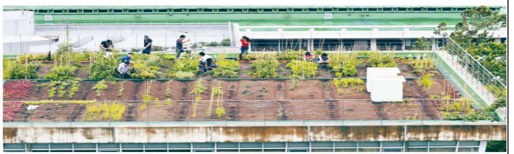
서울 관악구 신림동 서울대 공학관 옥상에서 한양대 교수 등이 조성한 텃밭에서 지난 11일 관악구 학생들과 교사, 청소년들이 모여 텃밭을 보며 있다. 840㎡인 이 텃밭은 하루 400여kg의 빗물을 한 방울도 흘려보내지 않고 모을 수 있다. www.seoul.go.kr
