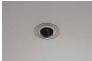
キヤノン S タワーのネットワークカメラ
