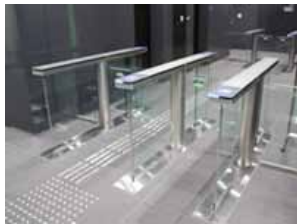
港南事業所のフラッパーゲート
