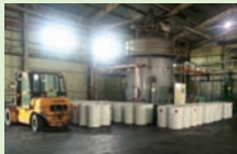
燃料化処理施設
