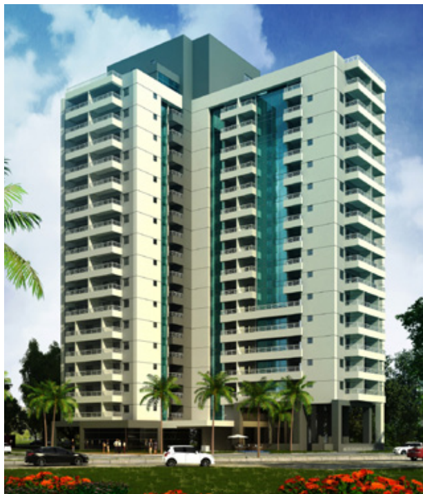
Empreendimento misto Marco Zero Mix, em São Bernardo do Campo-SP
