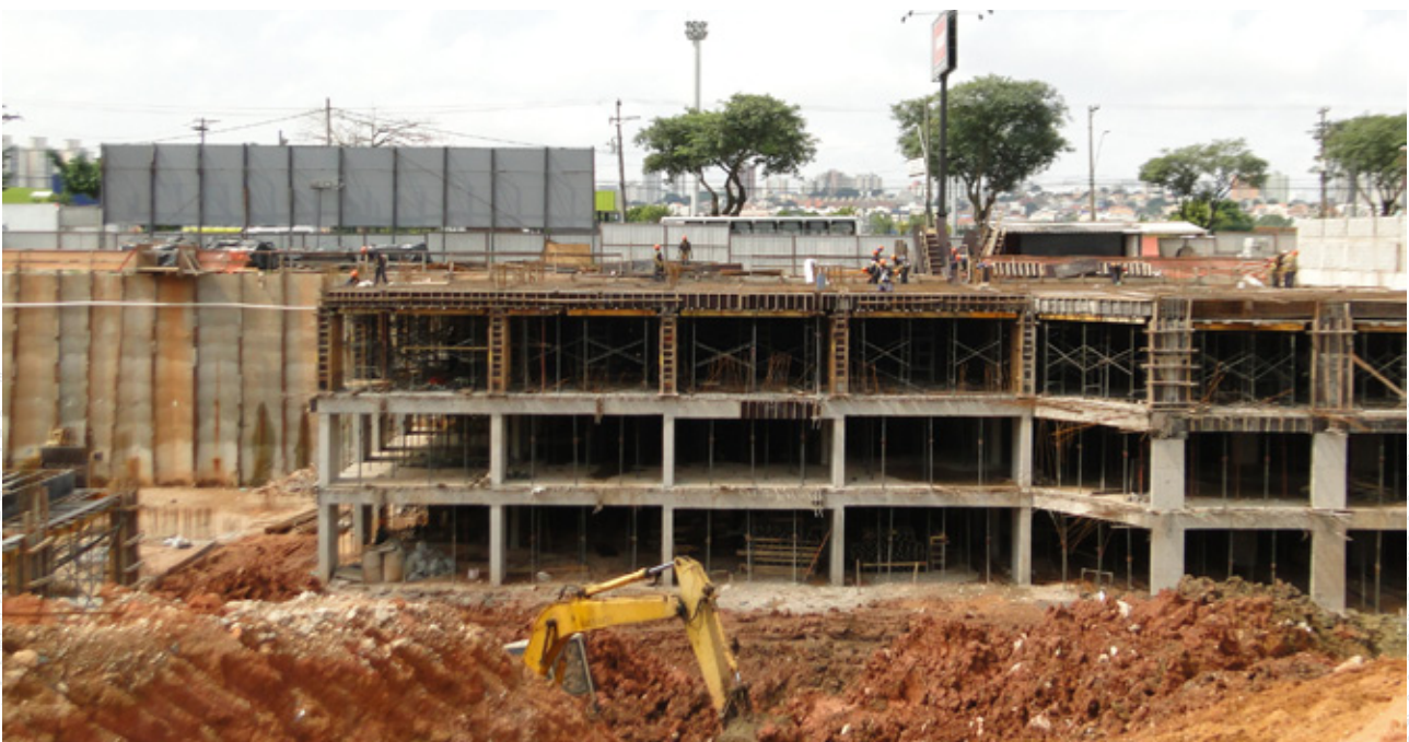
Construção do empreendimento misto Marco Zero São Bernardo, maior obra da MBigucci
