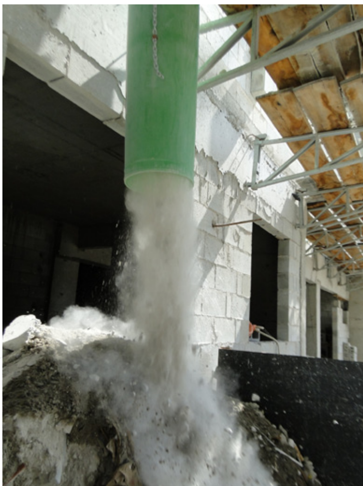
Condutor de entulho na obra Olympic, em São Paulo
