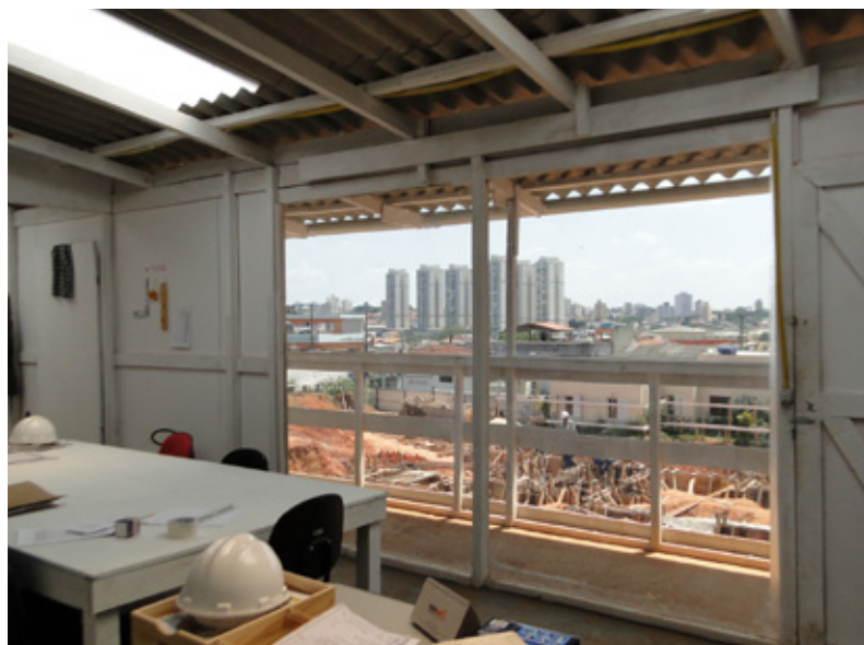
Telhas transparentes, garrafas Pet no telhado e parede de vidro no escritório proporcionam excelente iluminação natural, contribuindo para a redução de energia elétrica nos canteiros de obra
