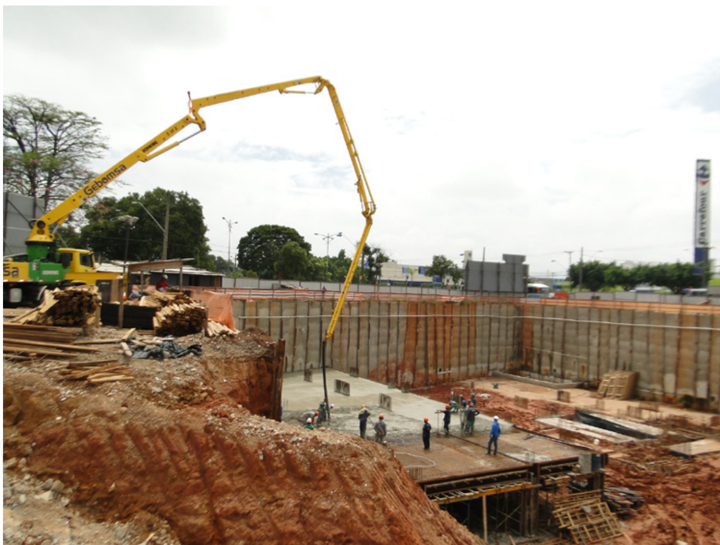
Marco Zero São Bernardo maior obra da MBigucci em construção
