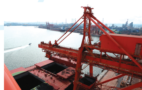
▲ 포항제철소 GTSU 전경
