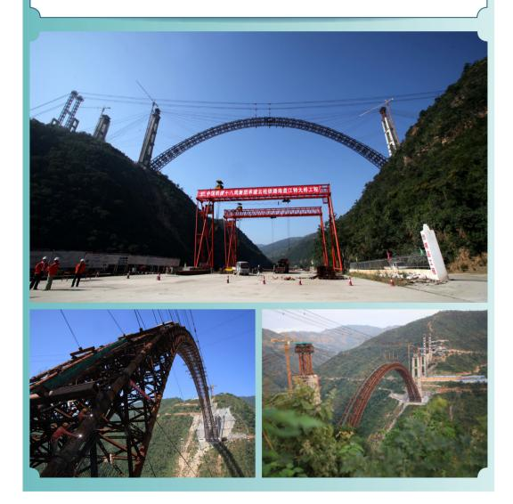
建成全长 1811 米、世界最长的钢管桁架梁公路桥——雅泸高速公路干海子特大桥。 该桥适合高地震烈度地域,技术水平国际领先;
