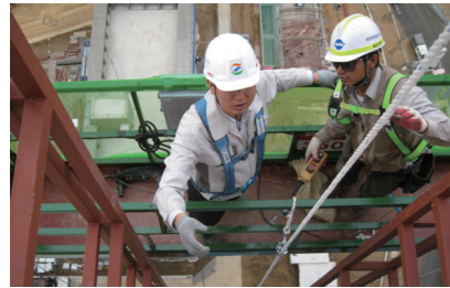
외형 조형물 설치용 콘도라 점검
