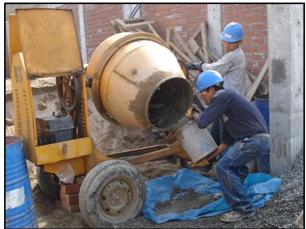
Control para evitar contaminación al suelo durante el vaciado de concreto
