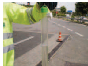
Aqua del separador de hidrocarburos después del tratamiento Biothy
