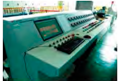
DC变流器试验系统
