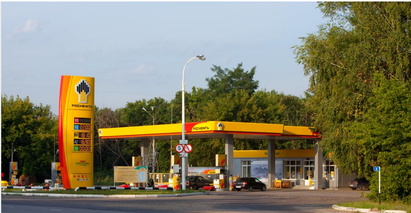
Filling complex #8 of Tambovnefteprodukt
