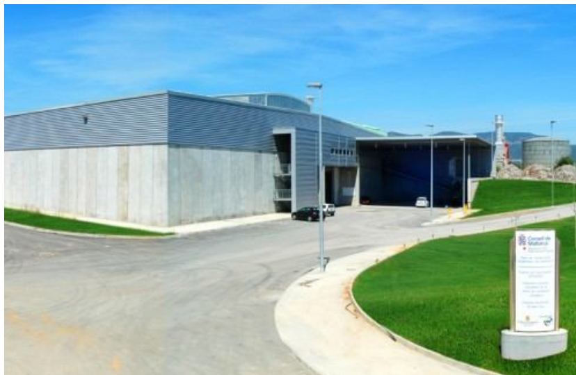
Planta de tratamiento de escorias.
