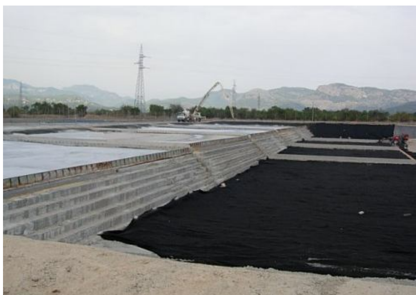
Depósito de seguridad de cenizas.
