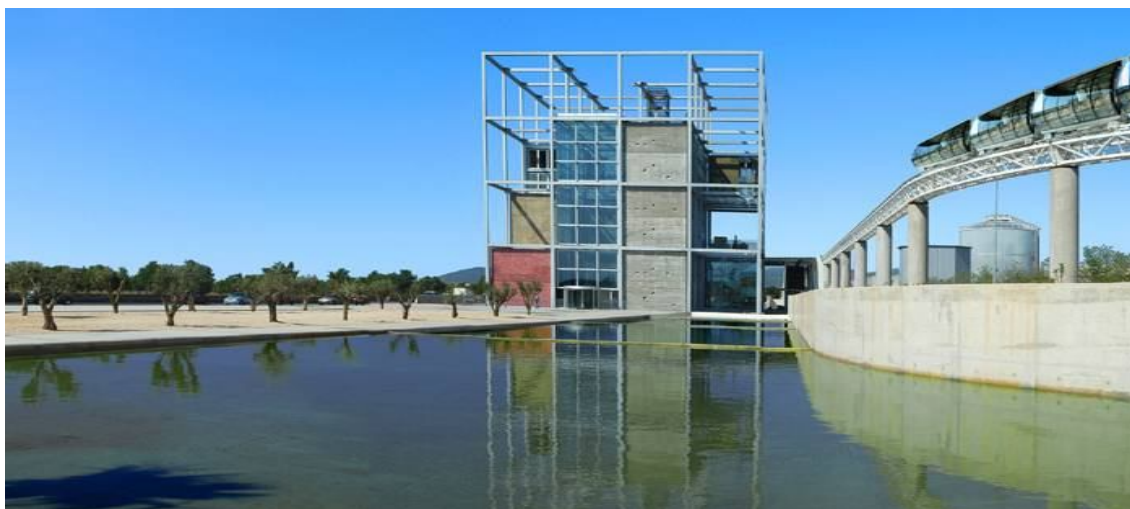
Edificio Central del Parque de Tecnologías Ambientales de Mallorca.
