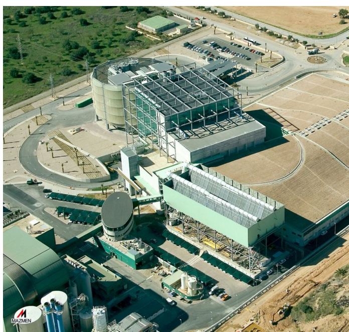
Planta de incineración de valorización energética.
