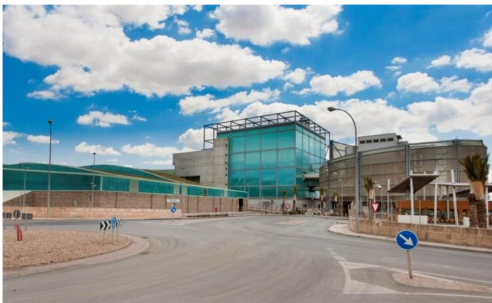
Planta de incineración de valorización energética.
