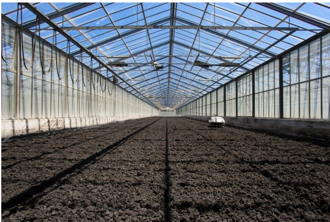
Planta de secado solar de lodos de depuradora.
