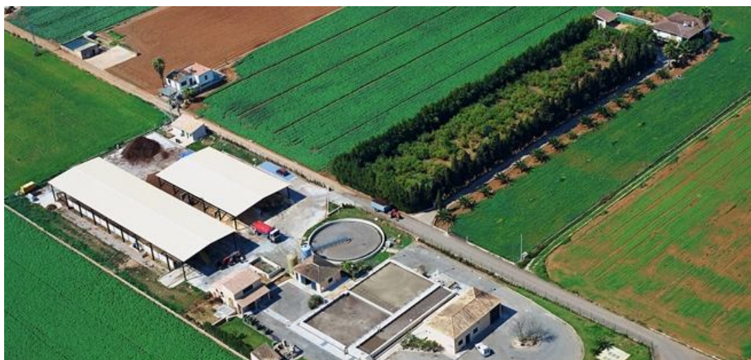
Planta de compostaje de lodos de depuradora.
