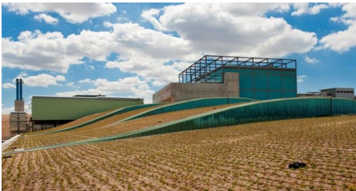
Planta de incineración de valorización energética.
