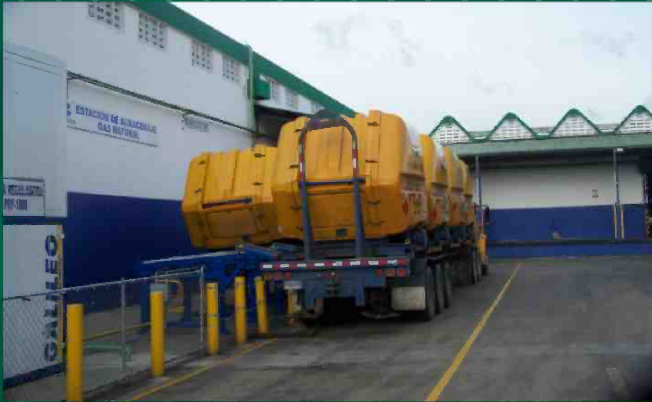
Vista general de instalación y camión transporte MAT's
