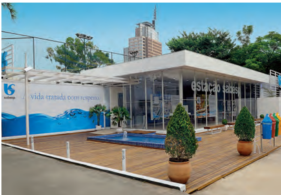
Estação Sabesp em Pinheiros, São Paulo
