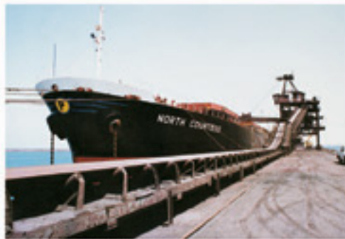
首钢秘鲁铁矿深水码头
