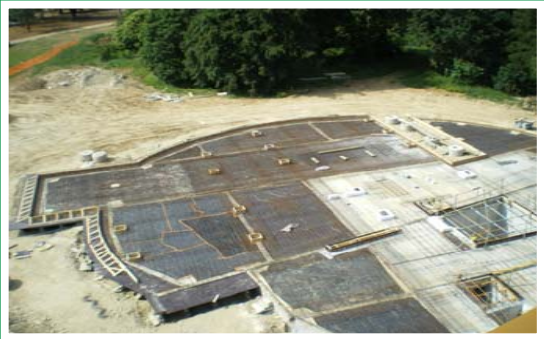
Photo de chantier pôle ever juin 2010
