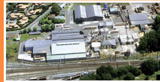
Usine de Labouheyre 11 000 m 2
