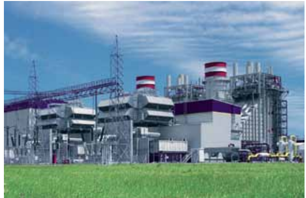
Central Termoeléctrica, Proyecto Genelba, Marcos Paz, Provincia de Buenos Aires.
