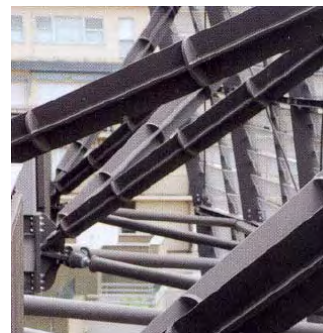
A sinistra: Dettaglio del nodo di attacco della facciata.
