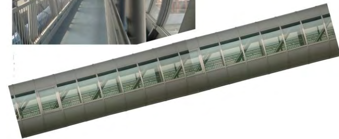
Sopra: vista, interna ed esterna, della passerella pedonale sospesa che funge da collegamento fra le due ali del fabbricato su via Stalingrado.
