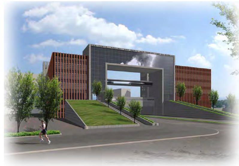
Sopra: Rendering con vista da via Stalingrado. A lato: Il cantiere.
