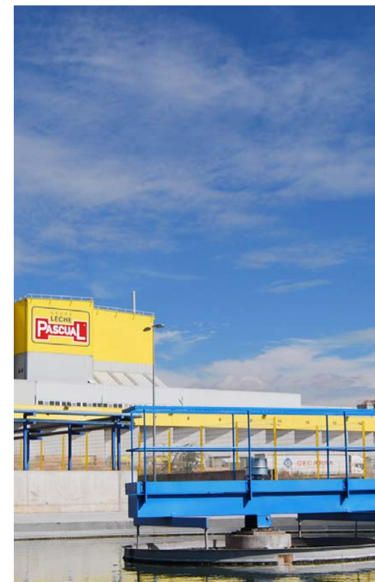
Depuradora del complejo de Aranda de Duero.
