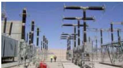
Para el proyecto **Escondida Power Transmission (EPT)**, Ingendesa concluyó durante el año 2009 los servicios de dirección de proyecto e ingeniería básica, que consideraron el diseño de nueve subestaciones (cinco de tipo convencional y cuatro tipo aisladas en gas SF6 - GIS) y de once líneas de transmisión en 220 kV y la elaboración de especificaciones técnicas de equipos y materiales, además de la planificación y presupuestación del proyecto.
