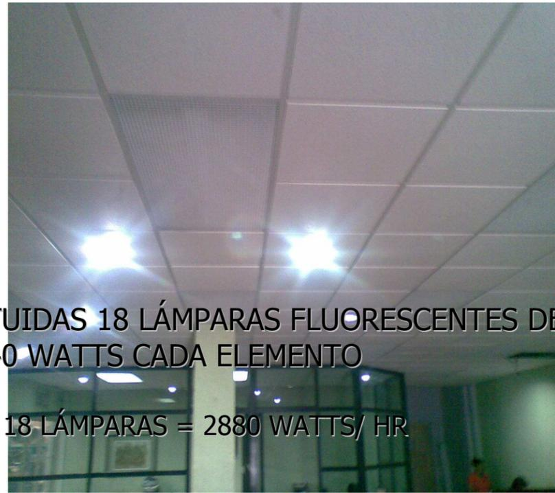
EN EL AREA DE OFICINAS FUERON SUSTITUIDAS 18 LÁMPARAS FLUORESCENTES DE CUATRO ELEMENTOS CON CONSUMO DE 40 WATTS CADA ELEMENTO
