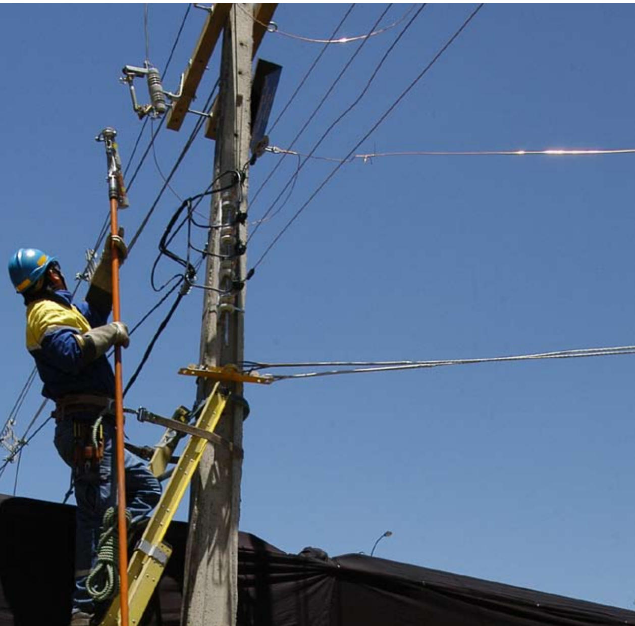
Trabajos en redes de media tensión.
