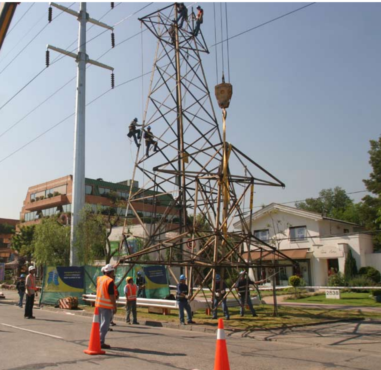
Trabajadores de Chilectra en la arriesgada tarea de reemplazar las antiguas torres de alta tensión, en Alonso de Córdova, por las de nuevo diseño.
