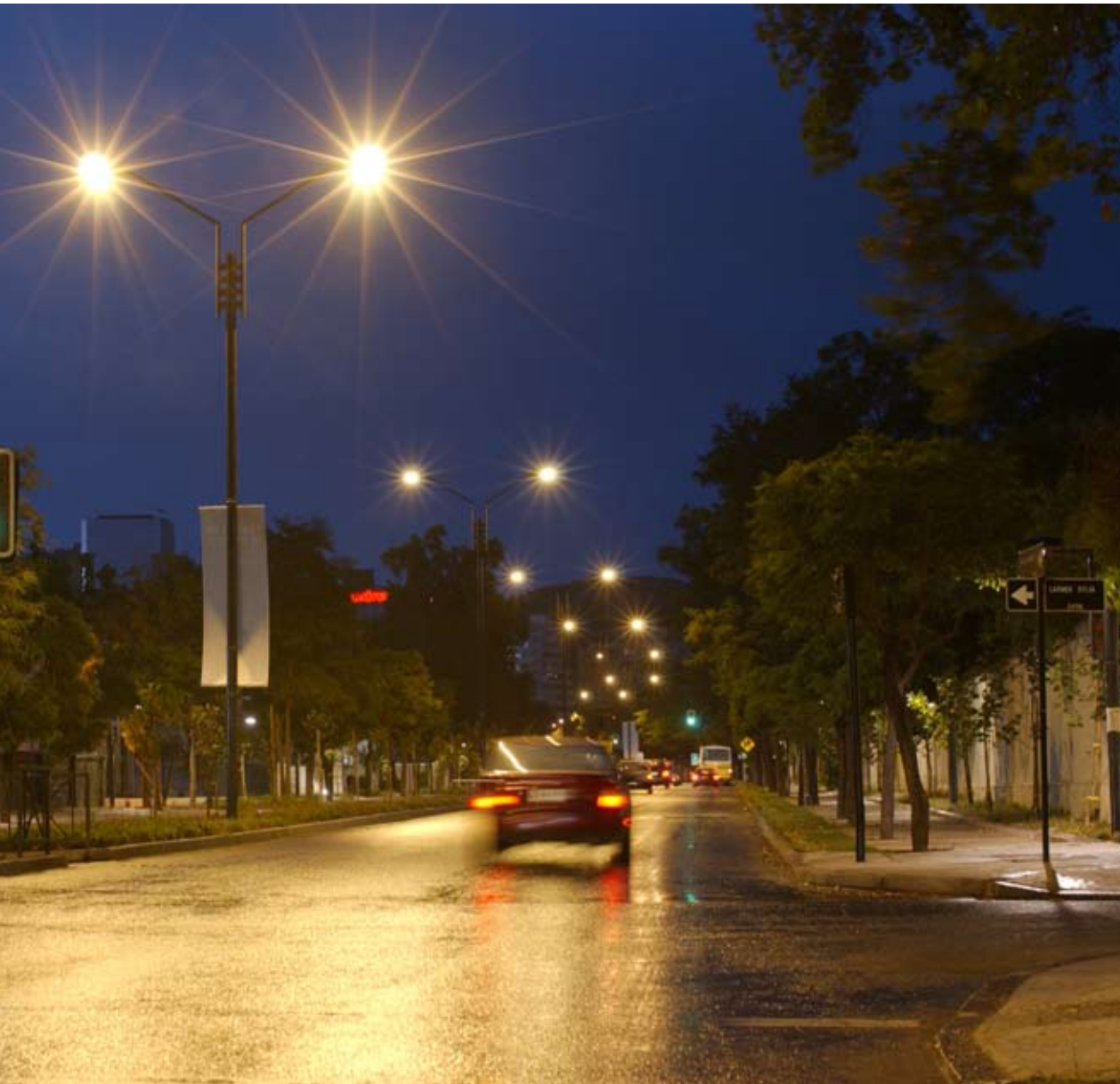
Modernización en el Alumbrado Público.
