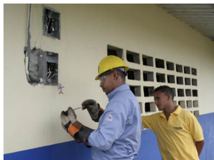
Instalación de medidor en la escuela Virgen de Guadalupe
