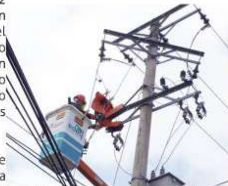
Trabajos técnicos en línea energizada
